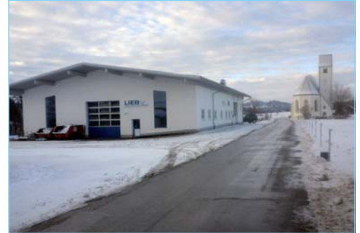
Betriebsgebäude Firma Lieb Errichtung einer Lagerhalle an der Ostseite
