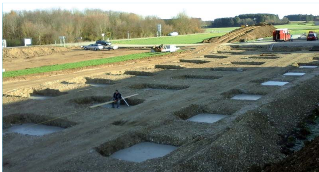
Baubeginn der Photovoltaik-Hallen November 2017
