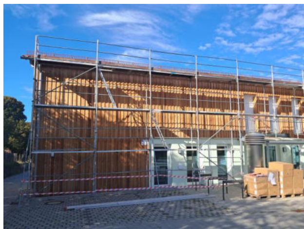
Eine Photovoltaikanlage für das Dorfgemeinschaftshaus.
